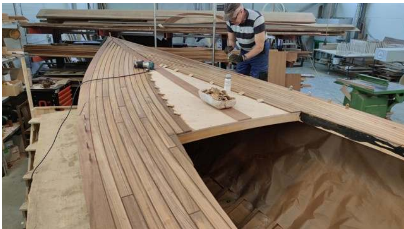
ON 38 Finerdekk lagt med dekkbelegg av limt natet teak.
