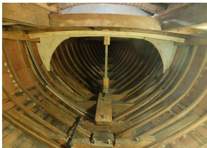
ON 35 Forsterkning dekk-skrog Foto Morten. H.H.
